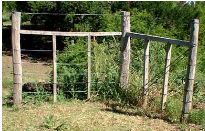
Doble arranque para alambrado de siete hilos en ángulo de 90° entrante acompañando la orografía del predio.
