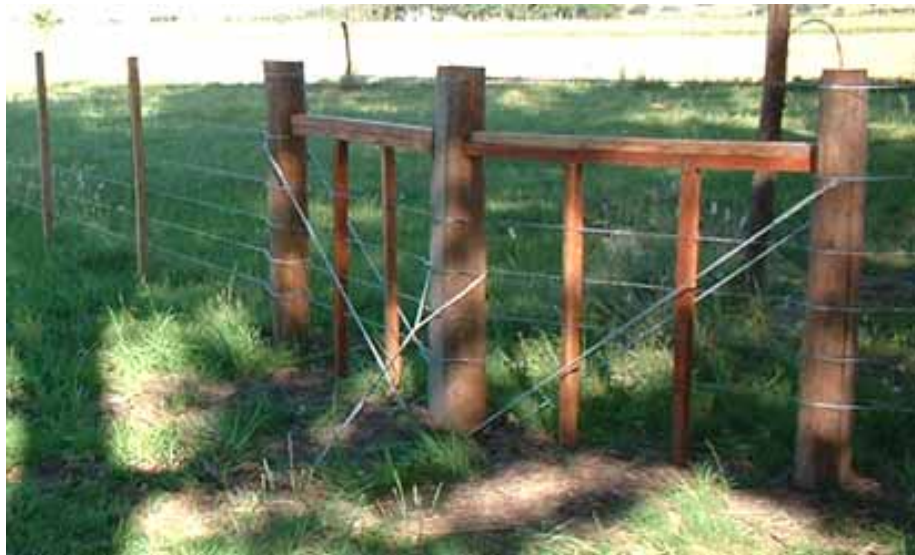
Arranque intermedio doble en ángulo de 150° para línea de seis hilos, con rienda externa en el poste central.
