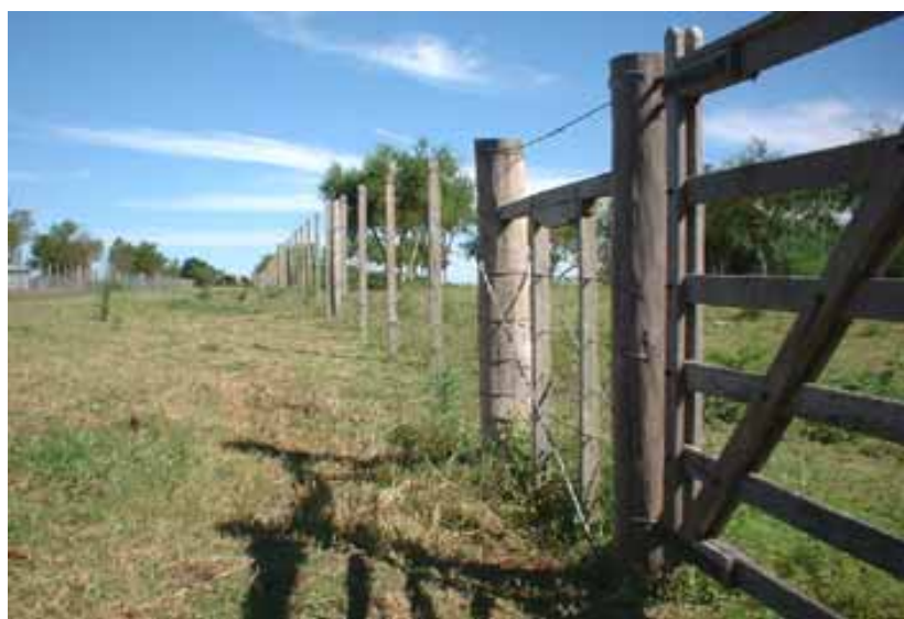
Vista en detalle de arranque a 180° para alambrado de siete hilos, línea y portera tipo ferrocarril.
