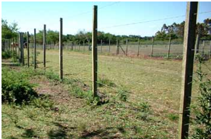
Vista de una línea de siete hilos.
